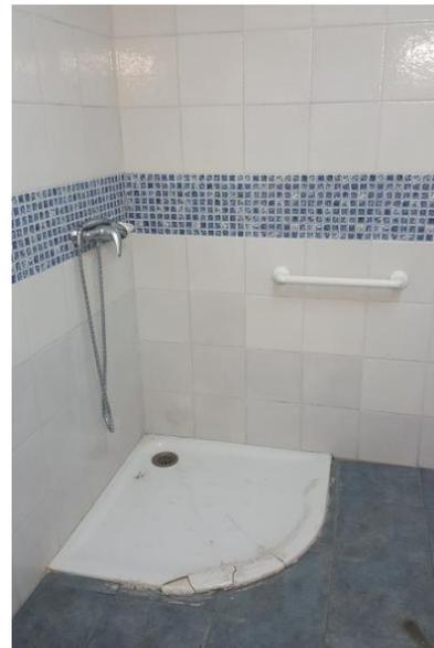
Analizando las mismas se recomendó lo siguiente: cambiar el plato de ducha e instalar un asiento anclado a la pared; bajar las barras del inodoro hasta la altura que indica la normativa; quitar el bidé que obstaculiza la maniobrabilidad; y cambiar el lavabo y los embellecedores de la puerta, por estar en mal estado.
